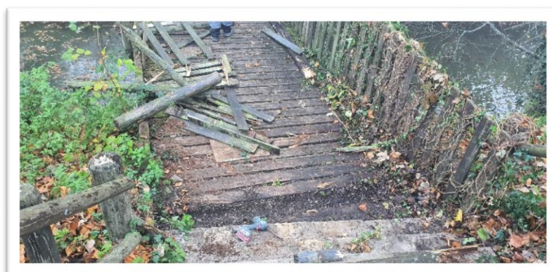
ENLEVEMENT DE LA PASSERELLE
